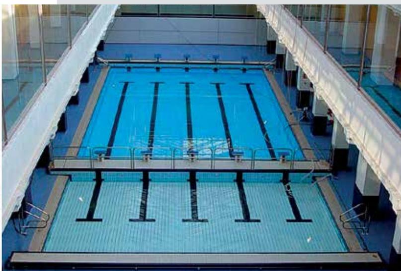
Dieses nicht schwimmende Hubboden-System wird über Hubschrauben, die in den Beckenwänden installiert sind, vertikal bewegt.
