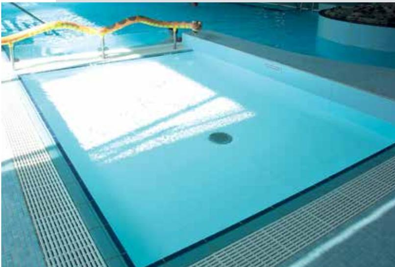
Die Verwendung traditioneller Bodeneinströmdüsen ermöglicht eine gleichmäßige, vertikale Beckendurchströmung und erfüllt damit alle Normanforderungen und gesetzlichen Vorgaben.
