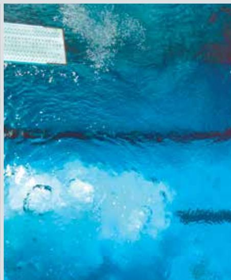
Eine optimale Mischung aus einströmendem Wasser und Luft reduziert den Widerstand der Wasseroberfläche und damit die einwirkenden Kräfte auf den Turmspringer im Moment des Eintauchens. Die unter den Sprungbrettern und -plattformen positionierte Luftkissen bieten unterschiedliche Einstellungsmöglichkeiten.
