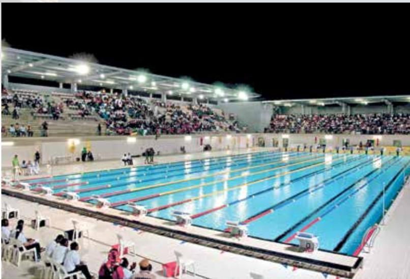
Nach den Regularien der Fédération Internationale de Natation (FINA), müssen Schwimmbecken mit Überlaufrinne auf 4 Seiten, mit 30 cm hohen aufsetzbaren Stirnwänden ausgerüstet werden. Diese dienen als Befestigung sowohl für Zeitmessplatten, als auch für Startblöcke und Schwimmleinen.
