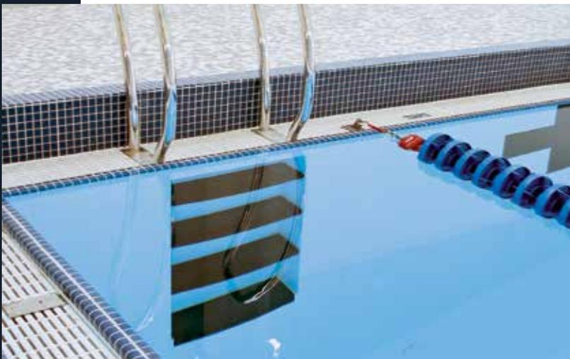
Die vormontierte Nischenleiter mit eingelassenen Trittstufen kann, wie alle anderen Paneele, ganz einfach in die Beckenkonstruktion eingefügt werden.
