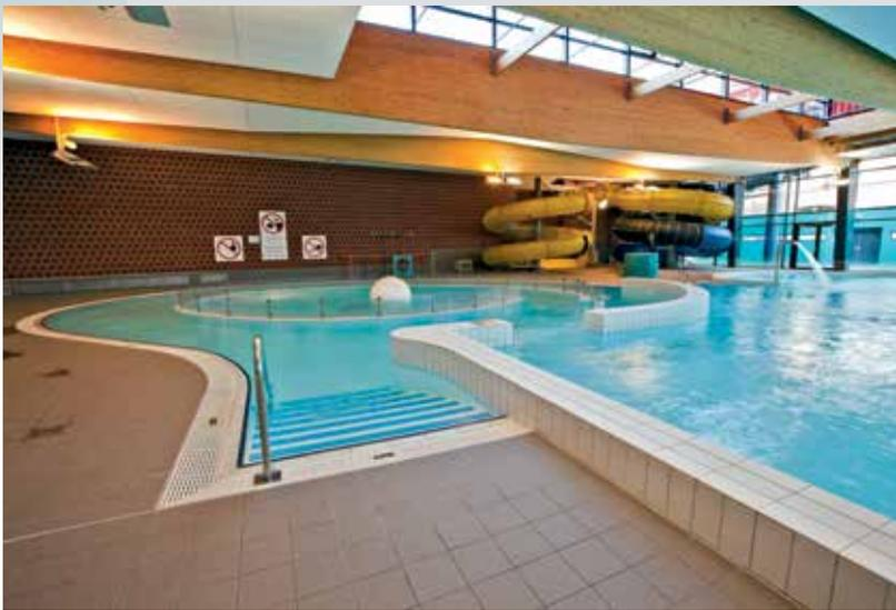
Zur Eingrenzung oder Trennung bestimmter Bereiche im Becken werden Einbauwände errichtet. Meist mit keramischen Fliesen oder anderen Materialien beschichtet, die sich dem umliegenden Design anpassen. Diese Einbauwände gibt es in quasi jeder erdenklichen Form.
