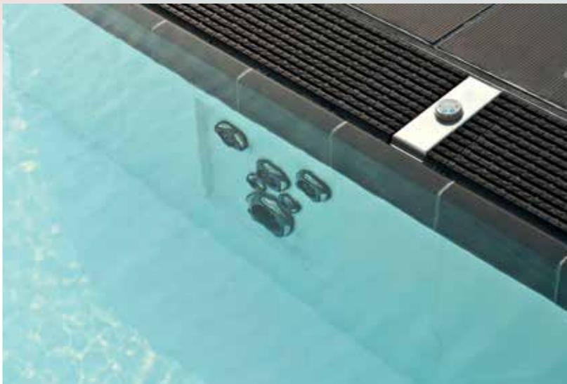
Die in der Wand eingelassenen Massagedüsen sind in verschiedenen Varianten erhältlich, die entweder Luft- oder Wasser ausstoßen. Die Massagedüsen werden über die in der Rinne installierte Bedienung aktiviert.
