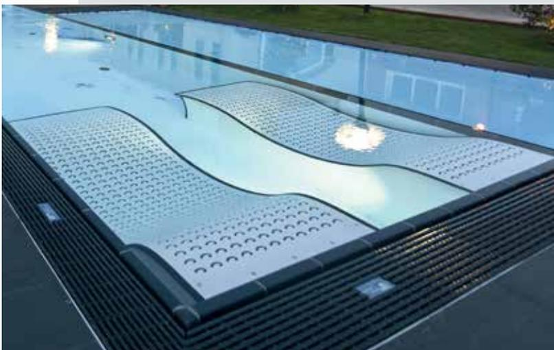
Die Hydromassage-Air-Lounger vermitteln Komfort und Eleganz. Die Air Lounges werden aus ergonomischen Paneelen hergestellt, die über eine spezielle PVC-Beschichtung verfügen. Unter den ergonomisch geformten Paneelen befindet sich die Luftsprudelverteilung, die über eine Fernbedienung gesteuert werden kann.
