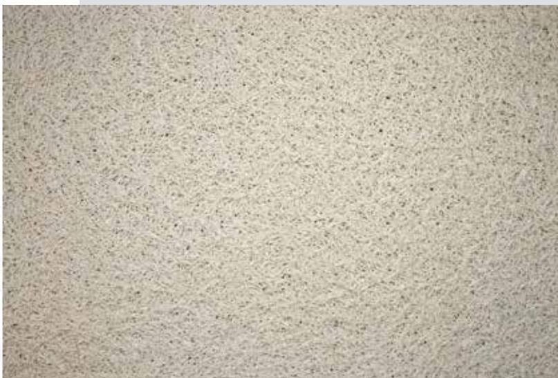
Der Softwalk® ist fest mit dem Boden verklebt und zusätzlich über eine spezielle PVC-Membran abgedichtet. Er erhöht Komfort sowie die Sicherheit im Becken und bietet im Falle von Vandalismus oder ungewollter Beschädigungen einen zusätzlichen Schutz.
